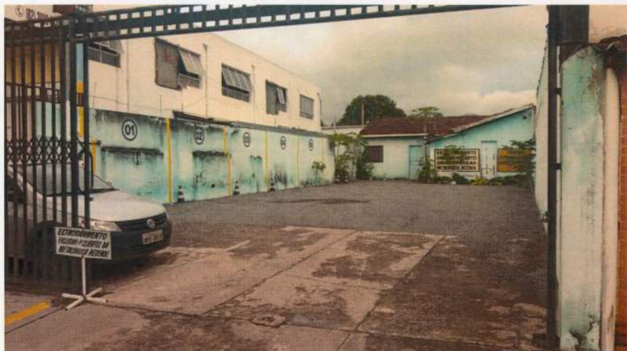
Foto 10 e 11 - Vista Fachada Frontal Estacionamento
